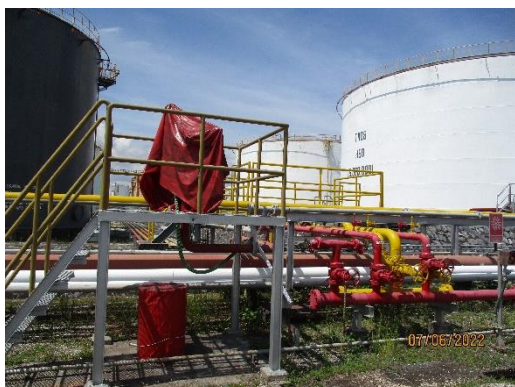
ภาพที่ 2-21 การติดตั้งอุปกรณ์ป้องกันรับเหตุอัคคีภัยและอุปกรณ์ล้างตาฉุกเฉิน ภายในบริเวณพื้นที่ปฏิบัติงานคลัง
