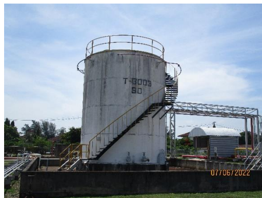
ภาพที่ 2-8 ถังเก็บรวบรวมน้ำมันจากบ่อดักไขมัน (Slop Tank)
