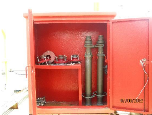
ภาพที่ 2-22 การติดตั้งอุปกรณ์ป้องกันระงับเหตุอัคคีภัยและอุปกรณ์ล้างตาฉุกเฉิน ภายในบริเวณพื้นที่ทำแทียบเรือ
