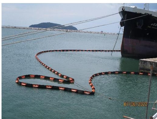
ภาพที่ 2-2 การติดตั้งอุปกรณ์ป้องกันการรั่วไหลน้ำมัน ขณะมีกิจกรรมการขนถ่าย
