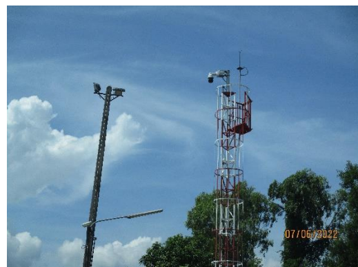
ภาพที่ 2-15 การติดตั้งกล้องวงจรปิด และไฟส่องสว่าง บริเวณพื้นที่ปฏิบัติงานคลัง
