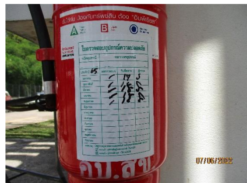
ภาพที่ 2-25 ตัวอย่างการตรวจสอบประสิทธิภาพอุปกรณ์ระงับเหตุอัคคีภัยของโครงการ
