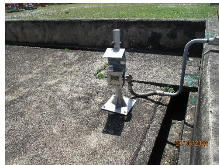
ภาพที่ 2-28 อุปกรณ์ตรวจวัดก๊าซ (Gas Detector) บริเวณที่เก็บ LPG ภายในพื้นที่โครงการ
