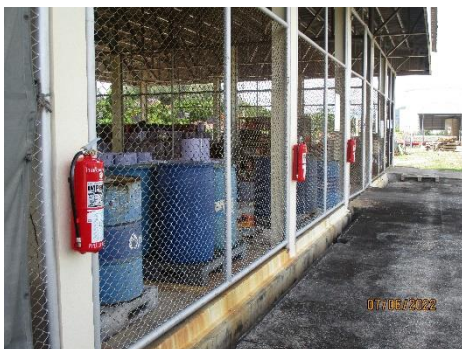
ภาพที่ 2-18 อาคารเก็บกากของเสียของโครงการ พร้อมทั้งการติดตั้งป้ายเตือนและป้ายห้ามต่าง ๆ และการติดตั้งอุปกรณ์ระงับเหตุอัคคีภัยใกล้เคียงกับพื้นที่อาคารเก็บกากของเสีย
